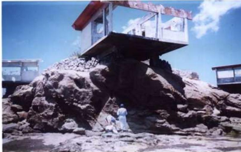
Foto 2.- Una de las viviendas destruidas por la socavación de la base del acantilado.
