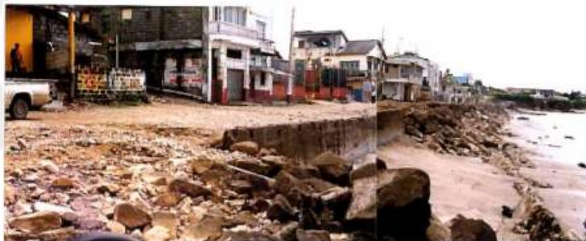
Foto 4.- Antiguo muro de contención, de concreto, del balneario La Libertad, completamente destruido.
